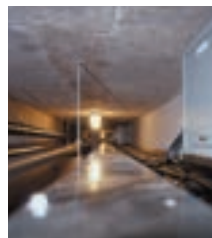
〈地下ピット内〉
