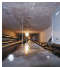
(地下ピット内)
